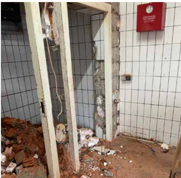
Abbruch der Kühlzellen
